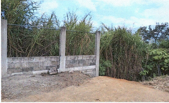
Foto 1: Mejoramiento de cerco perimetral
