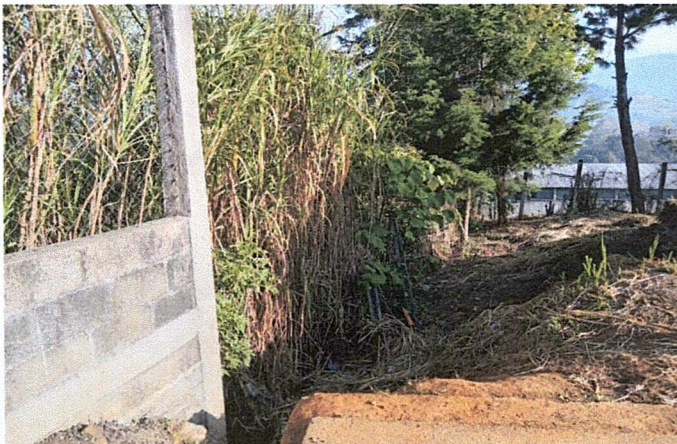
Foto 3: Mejoramiento de cerco perimetral
