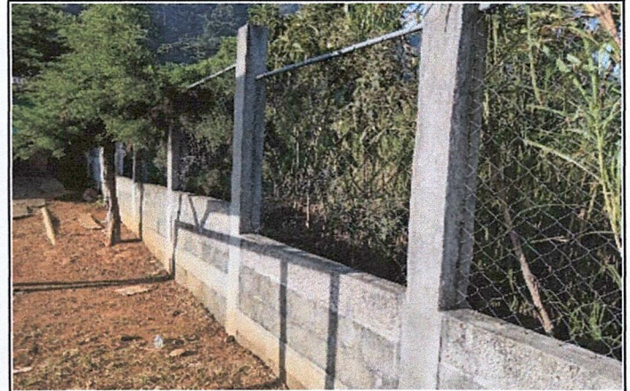
Foto 4: Mejoramiento de cerco perimetral
