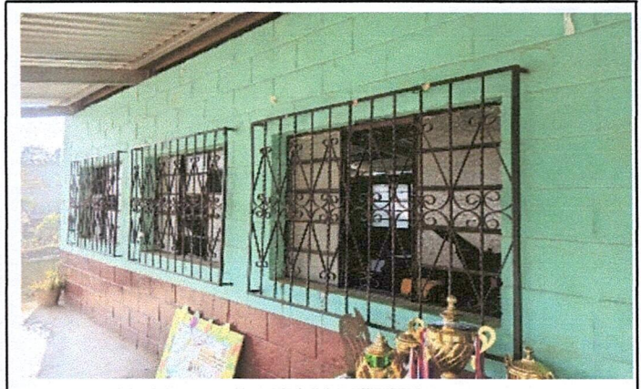
Foto 2: : Mejoramiento de aulas (piso cerámico de alto impacto)
