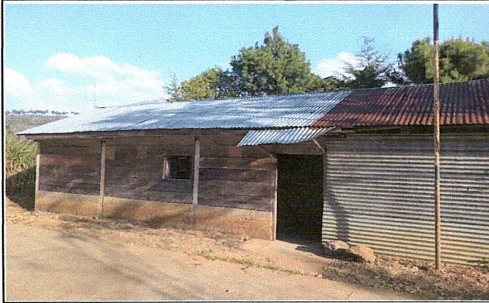
Foto 1: Mejoramiento de aula tipo pórtico
