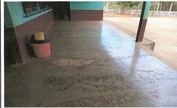
Foto 3: Mejoramiento de loza de patio
